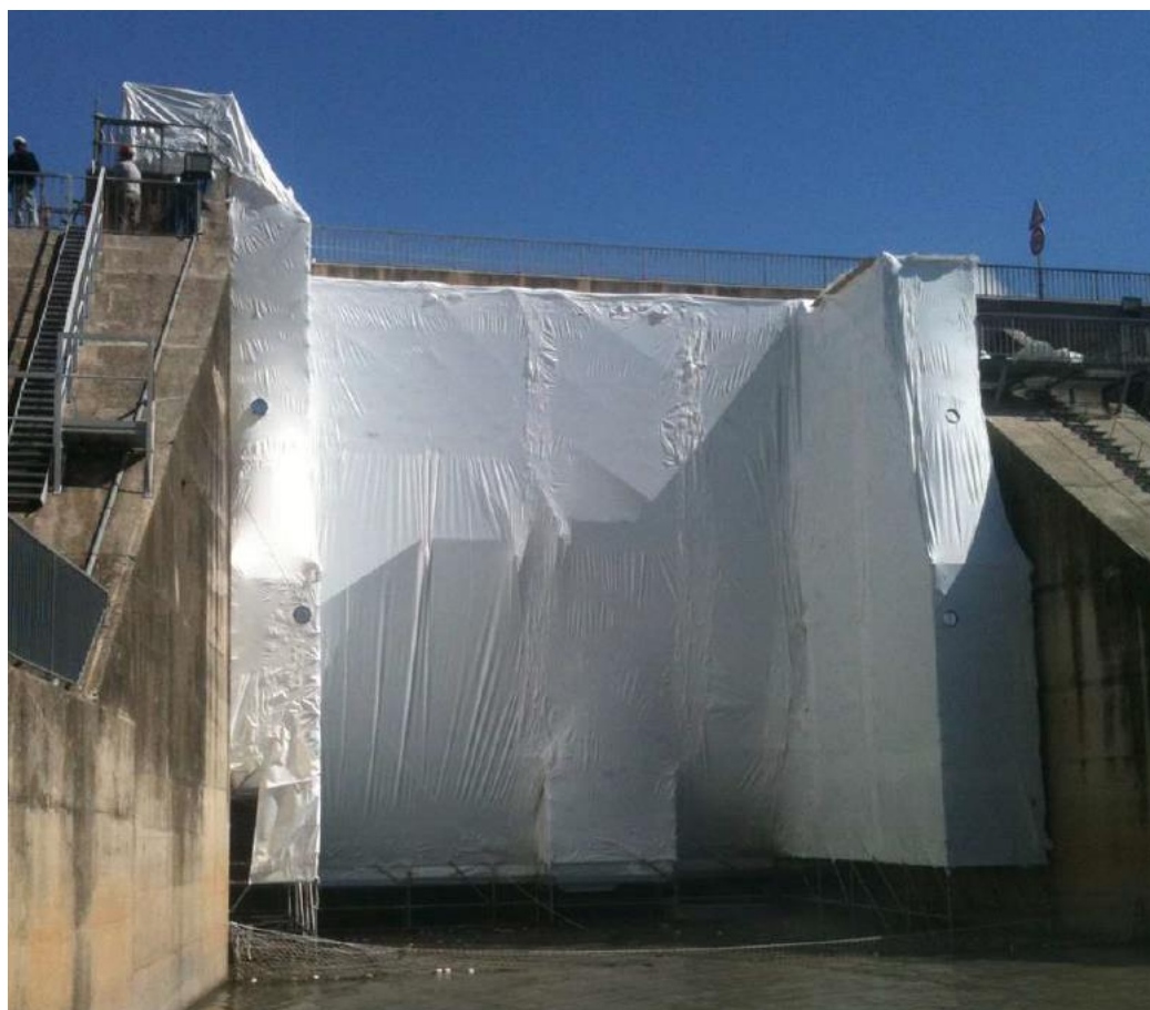
Photo 10 – Confinement d'une vanne avec l'aval en eau
