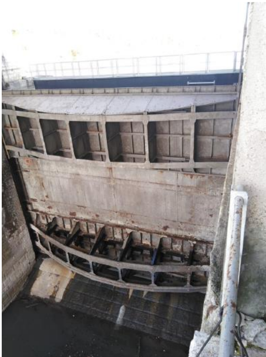
Photo 3 - Vanne Stoney avec structure à l'aval et à l'amont (non visible) - Structure rivetée
