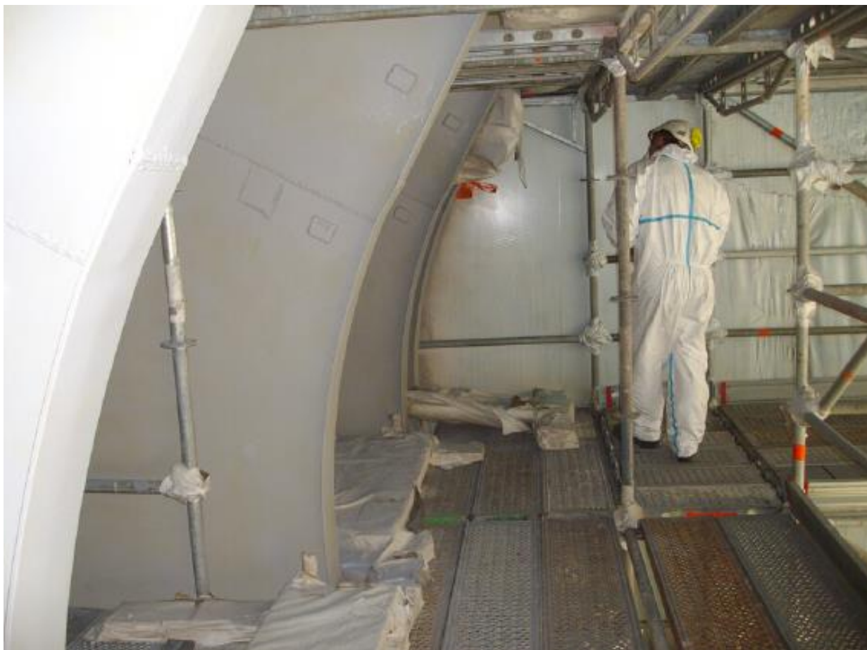
Photo 12 – Intérieur d'un confinement et protection de l'échafaudage avant peinture
