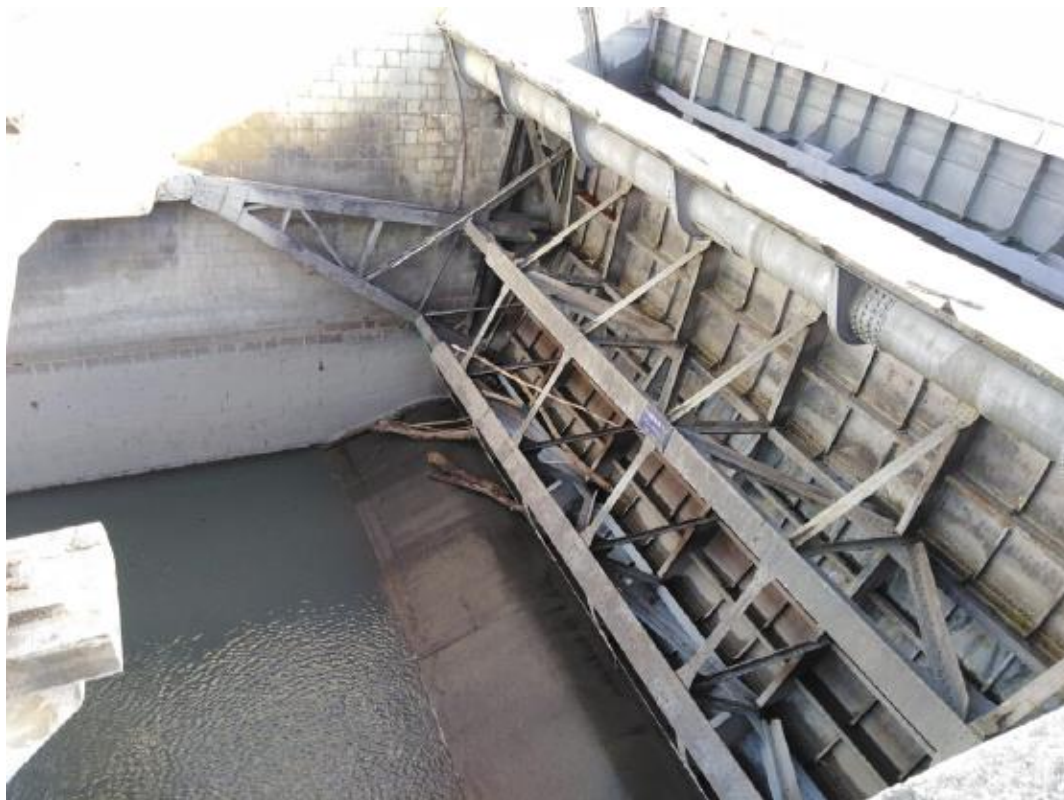
Photo 1 - Vanne segment avec clapet embarqué - Structure treillis rivetées
