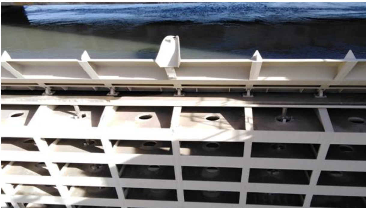
Photo 4 - Vanne wagon avec clapet embarqué - Structure PRS mécanosoudée
