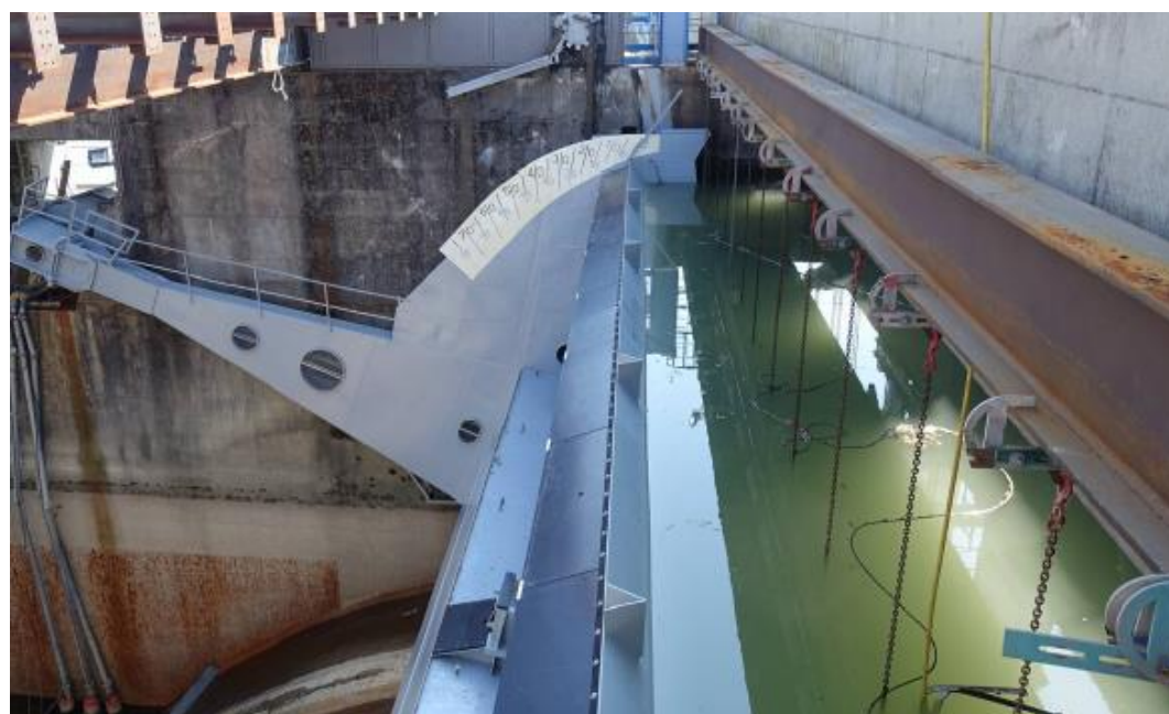
Photo 2 - Vanne segment avec clapet embarqué - Structure caisson mécanosoudée et PRS
