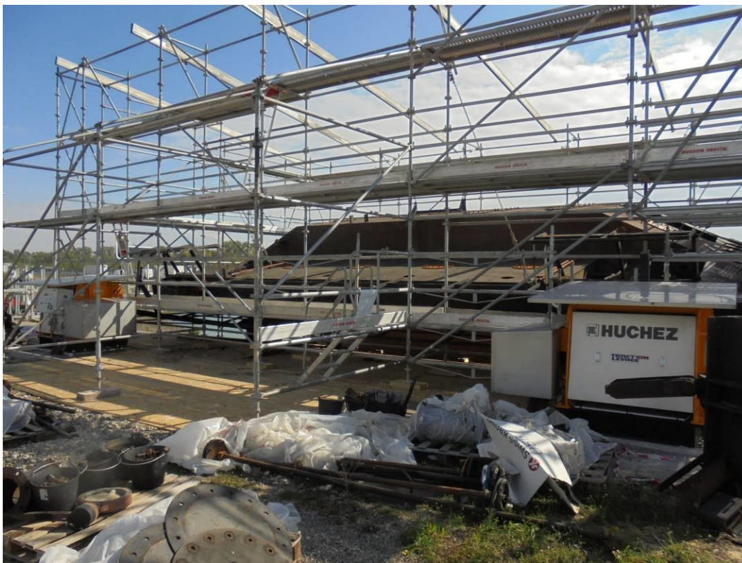
Photo 14 – Echafaudages en cours de montage autour d'un batardeau à terre
