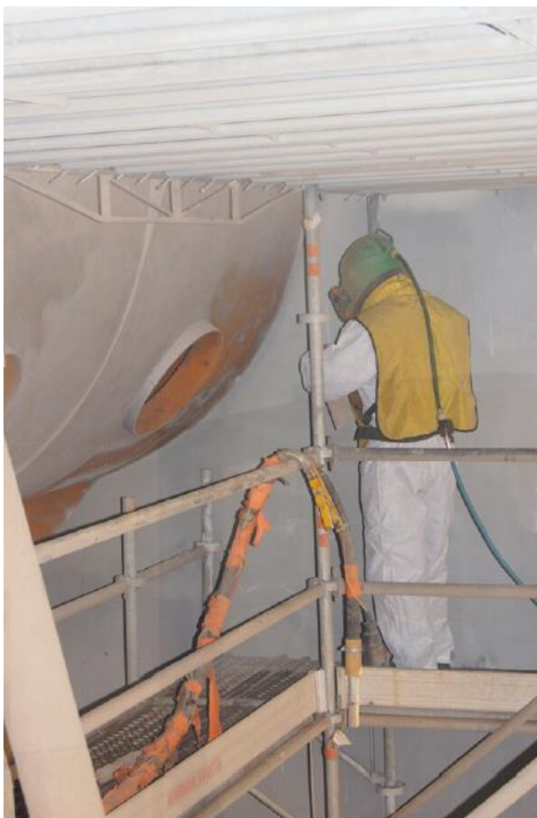
Photo 11 – Intérieur d'un confinement et équipement d'un opérateur lors du sablage
