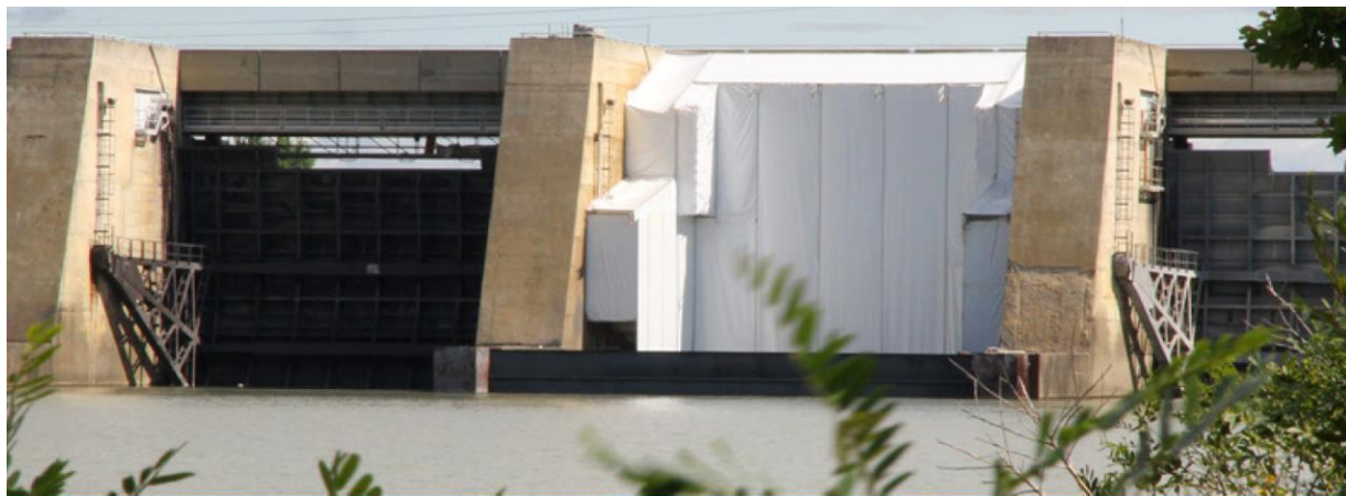
Photo 13 – Confinement d'une vanne derrière son batardeau aval
