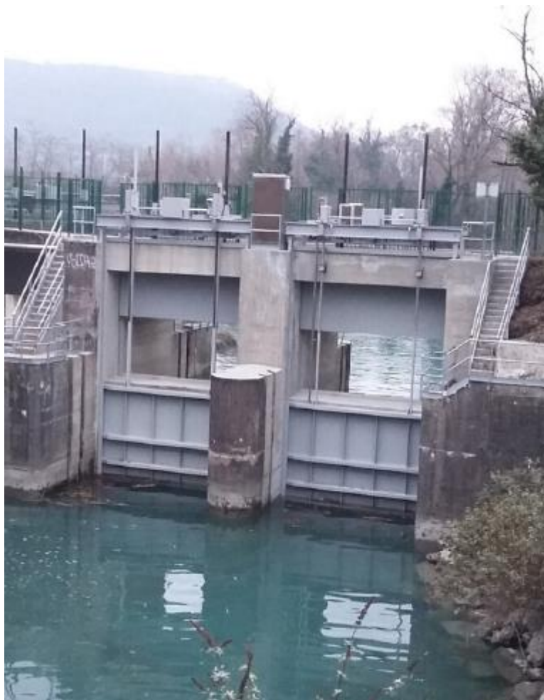
Photo 9 - Vanne à glissière. Structure mécanosoudée
