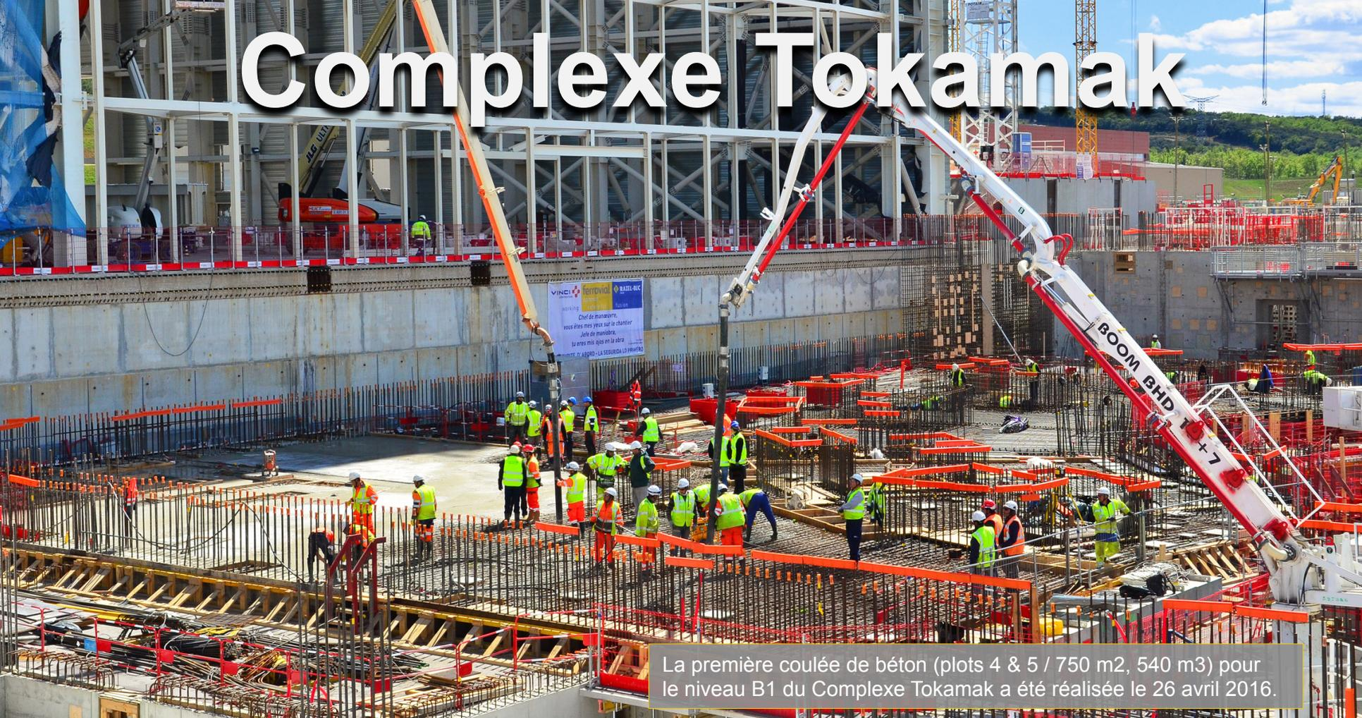
La première coulée de béton (plots 4 & 5 / 750 m<sup>2</sup>, 540 m<sup>3</sup>) pour le niveau B1 du Complexe Tokamak a été réalisée le 26 avril 2016.
