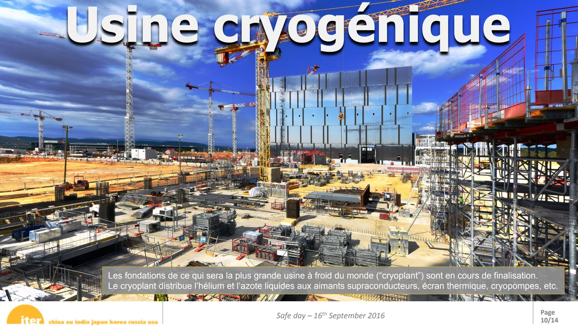
Les fondations de ce qui sera la plus grande usine à froid du monde ("cryoplant") sont en cours de finalisation. Le cryoplant distribue l'hélium et l'azote liquides aux aimants supraconducteurs, écran thermique, cryopompes, etc.
