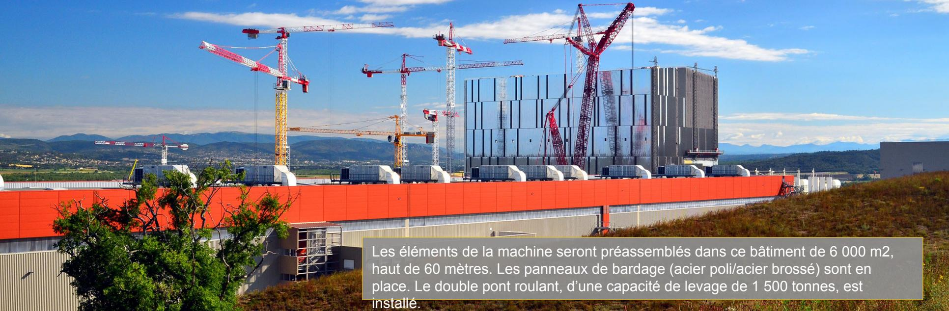
Les éléments de la machine seront préassemblés dans ce bâtiment de 6 000 m<sup>2</sup>, haut de 60 mètres. Les panneaux de bardage (acier poli/acier brossé) sont en place. Le double pont roulant, d'une capacité de levage de 1 500 tonnes, est installé.
